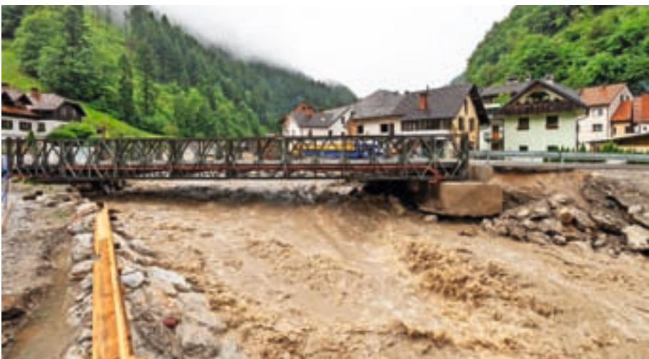
Narasla Selška Sora je spodkopala začasni most v Smolevo, zato so ga morali podbetonirati. / Foto: Simon Benedičič
